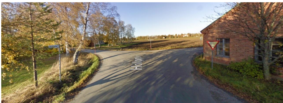
Kuva 16: Näkemä Faaringintien ja Hollontien liittymässä on huono
